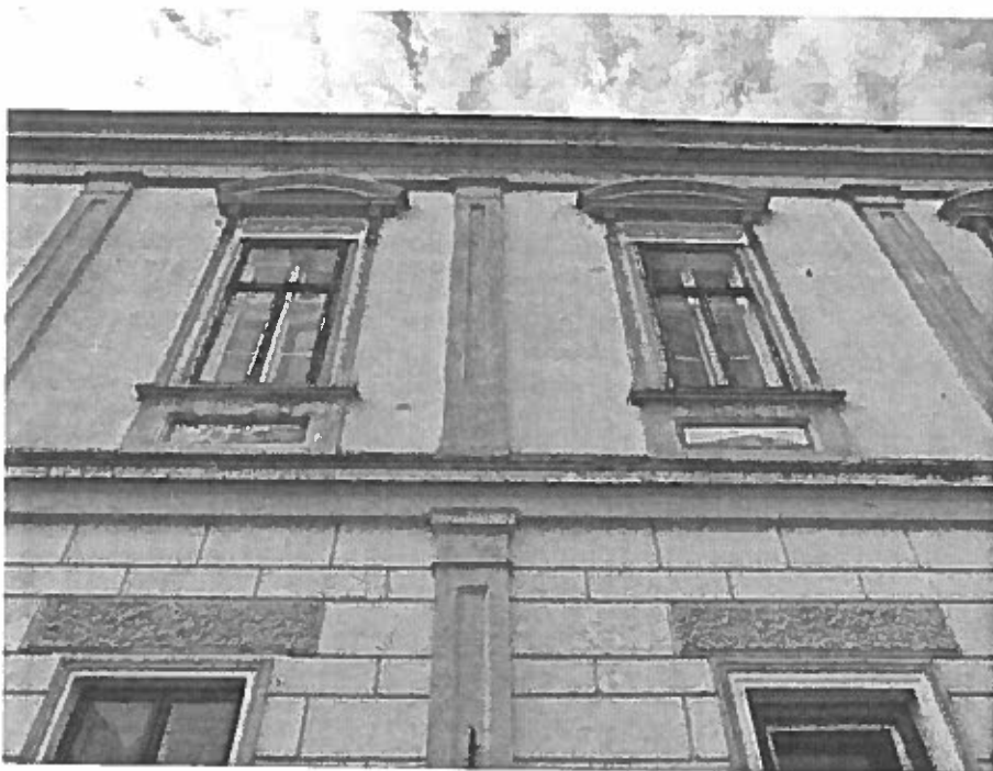
Az „olasz” neoreneszánszra a nyugodt tömegek, a nyílások szabályos ritmusa jellemző, valamint a klasszikus építészet alapvető tagozatainak – párkányok, keretezések, egyenes, vagy háromszögű szemöldökpárkányok, aediculák, pilaszterek, stb. – szakszerű, a formatan szigorú szabályainak megfelelő alkalmazása. Igaz, szemben a reneszánsz-kori mintaképekkel, mindezt vakolatból és gipszből.
