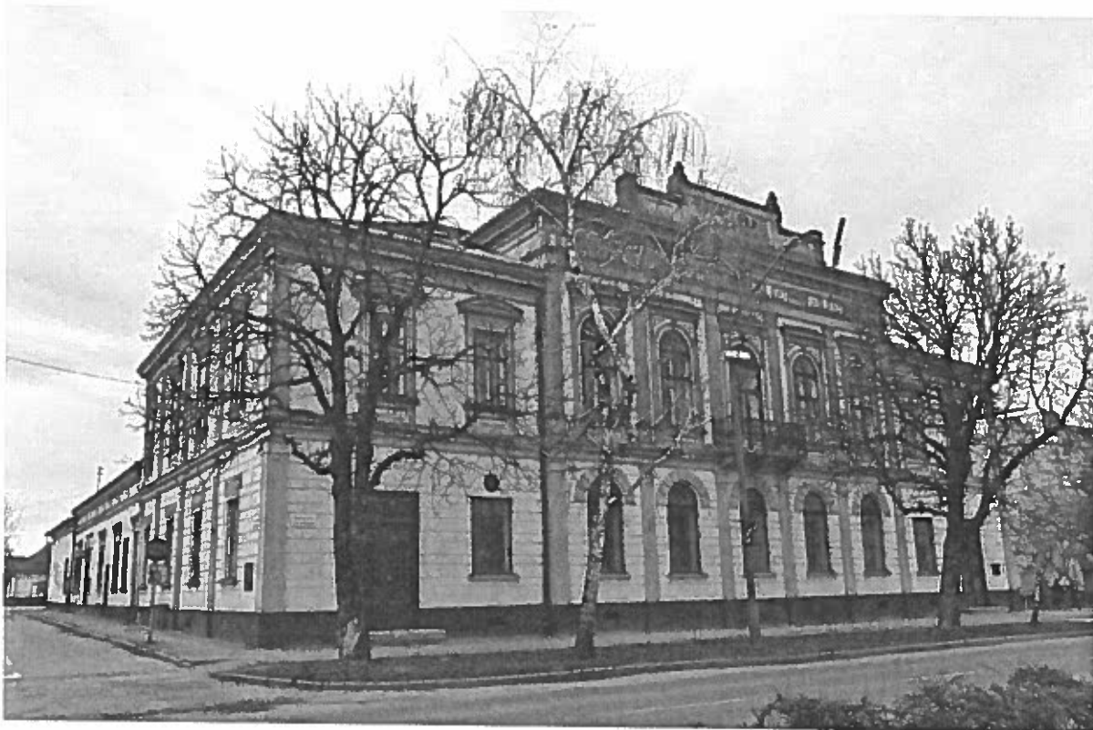
Az „olasz” neoreneszánszra a nyugodt tömegek, a nyílások szabályos ritmusa jellemző, valamint a klasszikus építészet alapvető tagozatainak – párkányok, keretezések, egyenes, vagy háromszögű szemöldökpárkányok, aediculák, pilaszterek, stb. – szakszerű, a formatan szigorú szabályainak megfelelő alkalmazása. Igaz, szemben a reneszánsz-kori mintaképekkel, mindezt vakolatból és gipszből.
