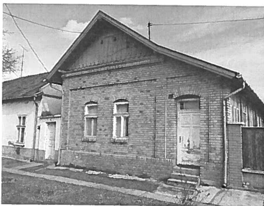
Lombfűrészszel készült, ún. „svájci” stílusú ormdísz, historizáló részletképzés, téglaburkolat és eklektikus asztalosszerkezetek. A népi tradíciót a deszkázott oromzat tulipánmotívuma és a ház fésűs beépítése, hagyományos tömegképzése képviseli.
