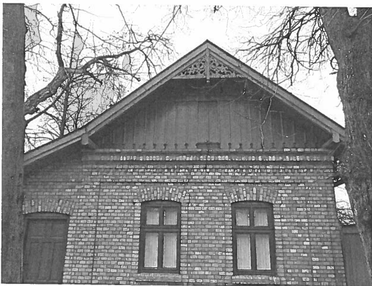
Lombfűrészszel készült, ún. „svájci” stílusú ormdísz, historizáló részletképzés, téglaburkolat és eklektikus asztalosszerkezetek. A népi tradíciót a deszkázott oromzat tulipánmotívuma és a ház fésűs beépítése, hagyományos tömegképzése képviseli.
